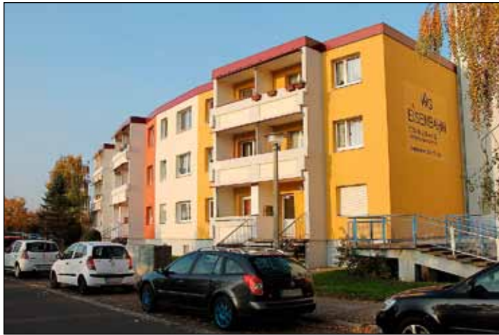
Sanierte Häuser der WG Eisenbahn in der Dresdener Straße: Freundlich, mit viel Platz zum Parken und komfortablen Wohnungen.
