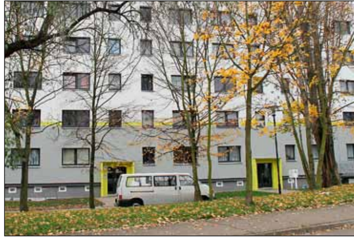
In den vergangenen Monaten sanierte die Hallesche Wohnungsgesellschaft mbH (HWG) 60 Wohnungen in der Jessener Straße 2 - 12 energetisch.
